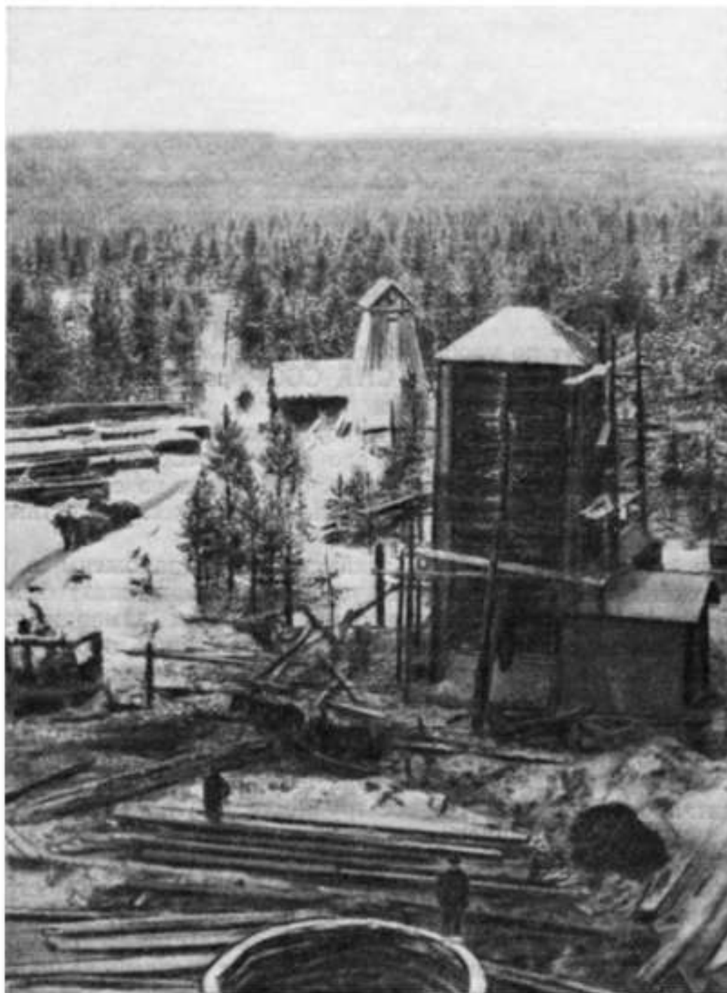
Строительство Соликамского калийного рудника (1927)
